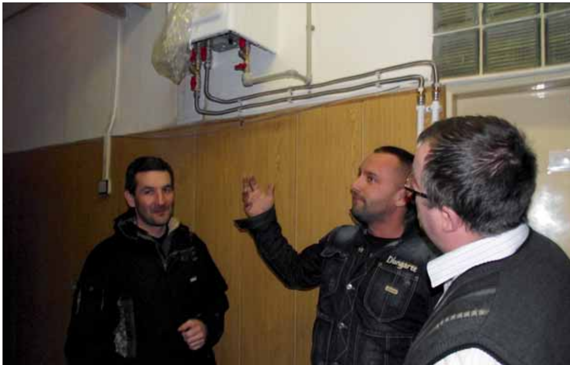
Posledné kontroly pred spustením nového kúrenia.
