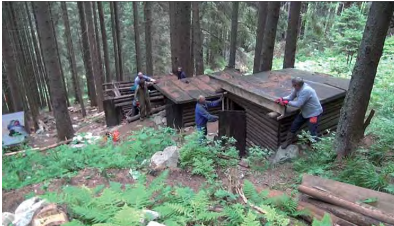
S obnovou bunkrov sa už začalo.
