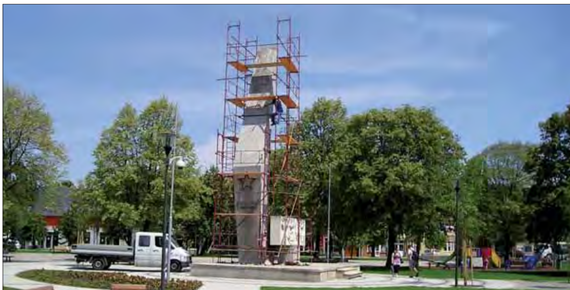
Pohľad na rekonštrukčné práce na pamätníku.
